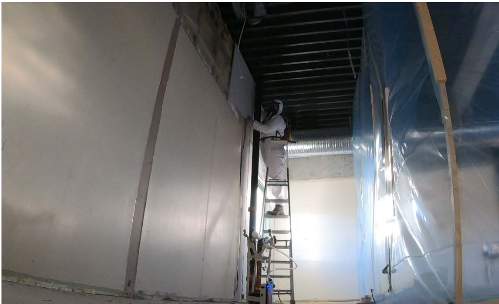
Figur 5.1: Bildet viser arbeid med sanering av veggplater i et innebygd saneringsområde
