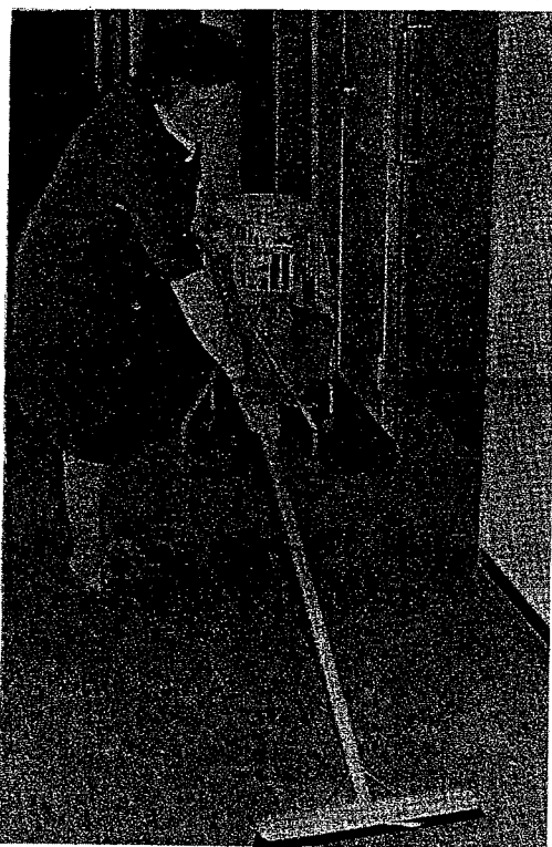
Figur 48. Naling av vann ved manuell oppskuring.
