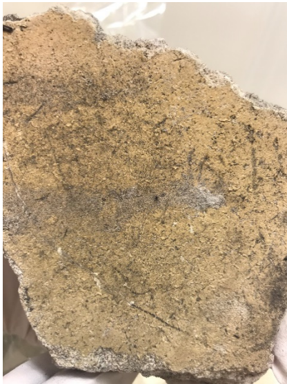
Figur 4.1: Del av innvendig skillevegg i et nedbrent hus (Foto: Torunn K. Ervik, STAMI)
