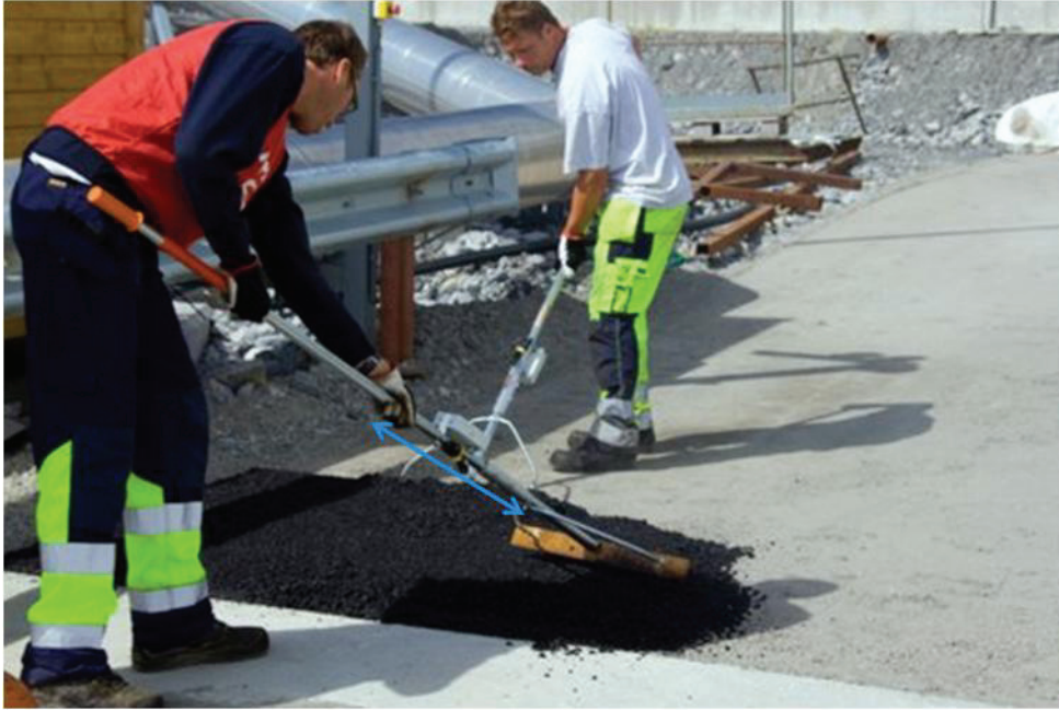
Bilde 3: Ombygd asfaltrake med kraftsensor (Fotograf Dag Steinar Tønder, Nordasfalt).
