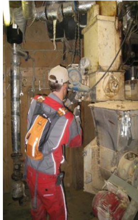
Reparasjon av fôrprensa
