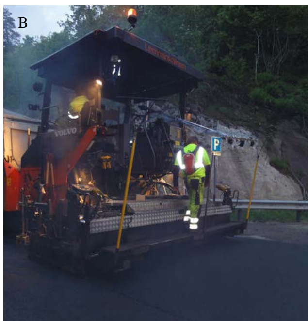
Bilde 1.A og 1.B: (A) Utlegging av PmB lavtemperaturasfalt (B) Utlegging av PmB varmasfalt (referanse).
